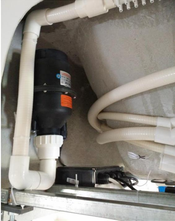
**ACHTUNG! BEVOR SIE DIE BADEWANNE VERWENDEN, SOLLTE DIE FESTE MUTTER DES LUFTDÜSENROHRS AN DER LUFTPUMPE FESTGEZOGEN WERDEN. FÜR DEN TRANSPORT WIRD DIE PUMPE VOM HAUPTKABEL GETRENNT.**
