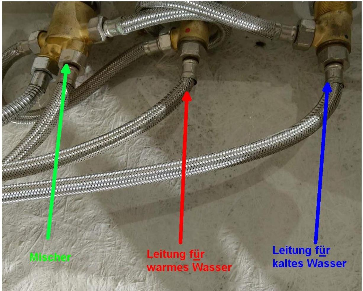
**Wichtig! Die der Wanne zugeführten Wasserschläuche dienen nur zur Produktprüfung. Für die ordnungsgemäße Verwendung des Produkts müssen Schläuche aus geflochtenem Edelstahl gemäß PN installiert werden.**
